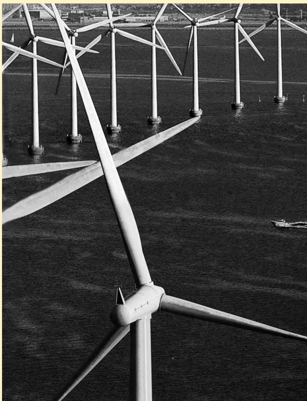
PARCO EOLICO OFFSHORE DI MIDDELGRUNDEN, DANIMARCA
